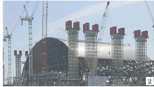
282. ábra. 1. Az 1986-os csernobili atomkatasztrófa. 2. Az új sarkofág építése 2016-ban a sérült 4-es blokk felett
