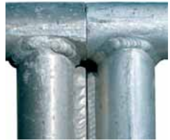
Мал. 5. Якість зварювального шва залежить від виду зварюваних сталей
