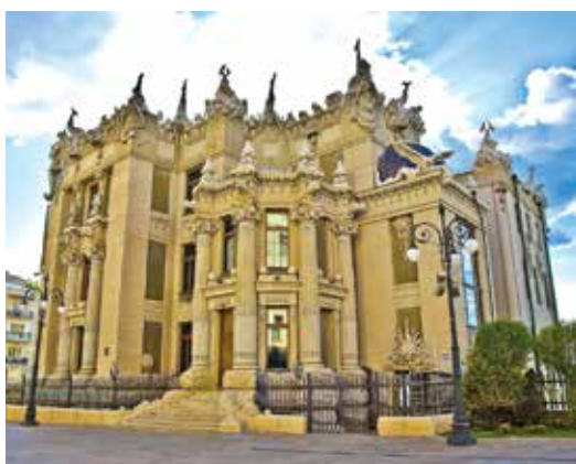
Будинок з химерами в Києві. Архітектор Владислав Городецький . Збудовано в 1902–1903 рр.
