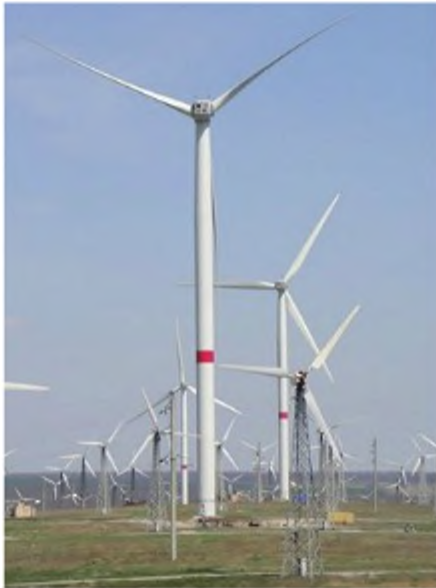
Рис. 17.3. Вітрові турбіни Новоазовської вітрової електростанції
