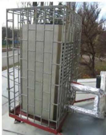
Тепловий насос "повітря-рідина" IVT, 17 кВт
