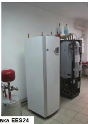
Теплові насоси "грунт-рідина" IVT 6 та 11 кВт
