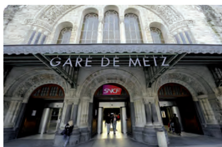
la gare ferroviaire
