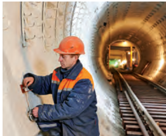
Creuser des tunnels
