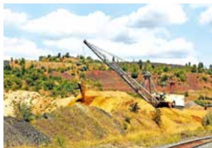
Рис. 182. Проведение лесной и горнотехнической рекультивации земель
