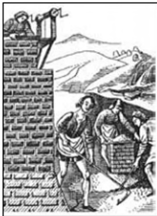
Праця каменярів на будівництві. З середньовічної мініатюри
