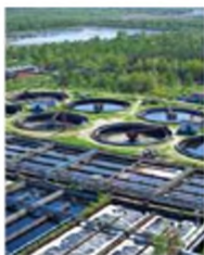
Станція очищення стічних вод
