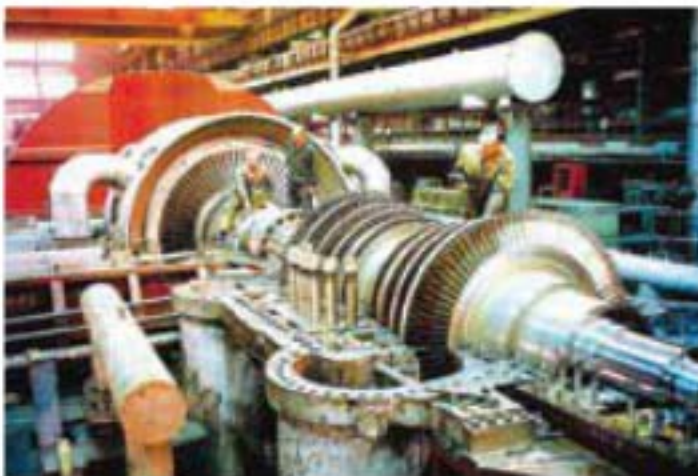
Рис. 226. Монтаж турбіни на заводі «Турбоатом» (м.Харків)
