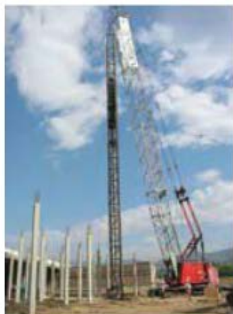
Рис. 222. Забивання палів під фундамент за допомогою будівельної машини — копера
