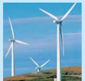
Мал. 31.3. Кінетичну енергію вітру вітросилові установки перетворюють на електричну енергію
