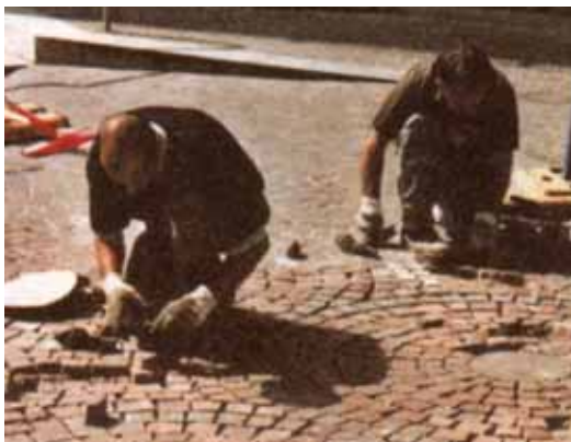
Мал. 2. Укладка цегли
