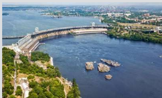
Гребля збудованої у 1930-х рр. Дніпровської гідроелектростанції, що перегороджує Дніпро й утворює Дніпровське водосховище площею 410 км 2 . Це водосховище затопило знамениті Дніпровські пороги
