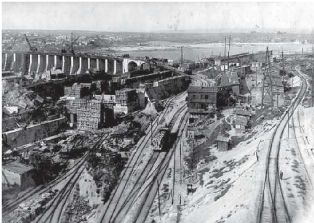
← На будівництві Дніпрогесу
