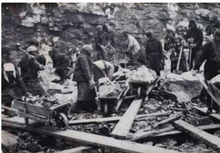
Робітники на будівництві Біломорсько-Балтійського каналу на півночі Росії. Фото. Початок 1930-х років
