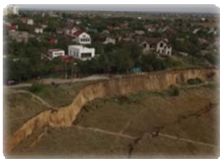
Зсув ґрунту в Одесі
