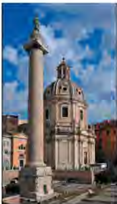
▲ Колона Траяна в Римі (сучасний вигляд)
