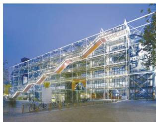
Le centre Pompidou
