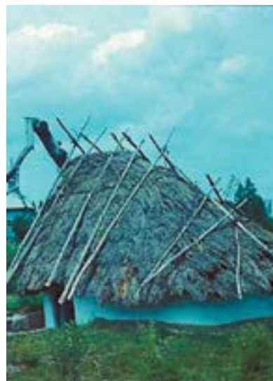
A csernyahovi kultúra lakóépületének mai rekonstrukciója.
