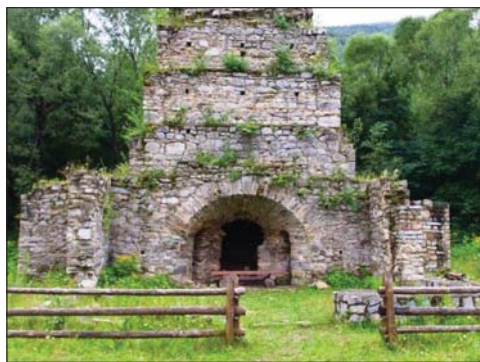
Мал. 115. Доменна піч (Івано-Франківщина), у якій виплавляли чавун двісті років тому
