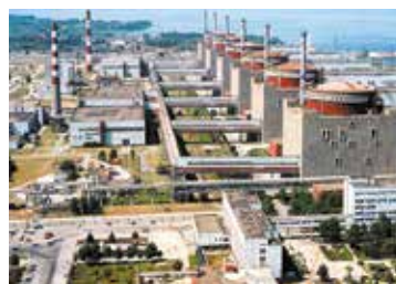
42.6. ábra. Zaporizzsjai Atomerőmű – Európa legnagyobb atomerőműve: 6 energiablokkjának teljesítménye egyenként 1000 MW
