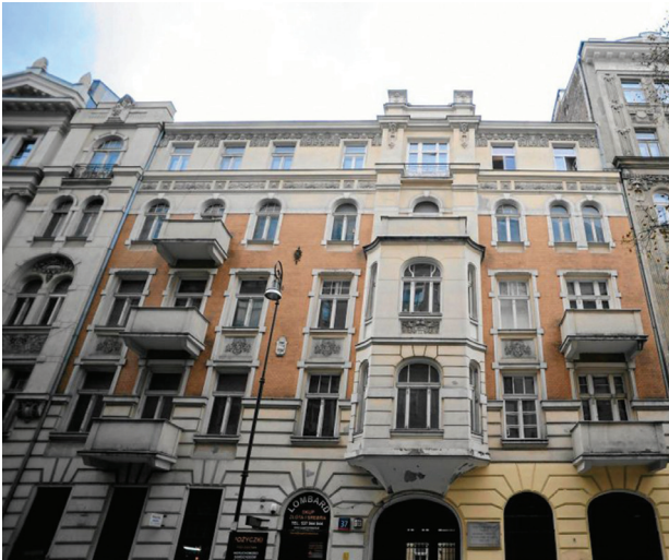
Kamienica przy Poznańskiej 37 w Warszawie, w której Miron Białoszewski mieszkał w latach 1945–1958
