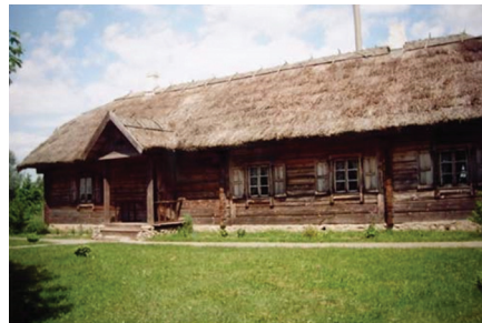
Zrekonstruowany dworek Mickiewicza w Zaosiu (obecnie wieś na Białorusi, w obwodzie brzeskim, w rejonie baranowickim). Fot. Wiktor Wystouch, 2008 r.
