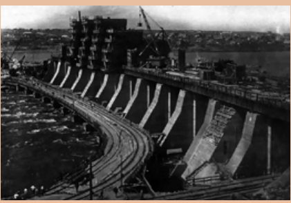
Будівництво Дніпровської гідроелектростанції. 1930 р.
