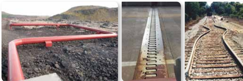
Мал. 180. Теплове розширення конструкцій
