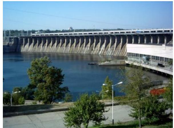
У наш час гідроелектростанції перетворюють енергію води на електричну. Щоб збільшити механічну енергію водної стихії, потрібно, щоб вода падала з більшої висоти, тому перед станцією будують греблю. Падаючи на лопаті машин, вода передає їм свою механічну енергію. А вже ці складні пристрій перетворюють механічну енергію на електричну.
