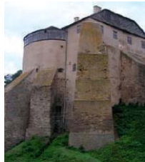
Мурована вежа Острозького замку. Світлина
