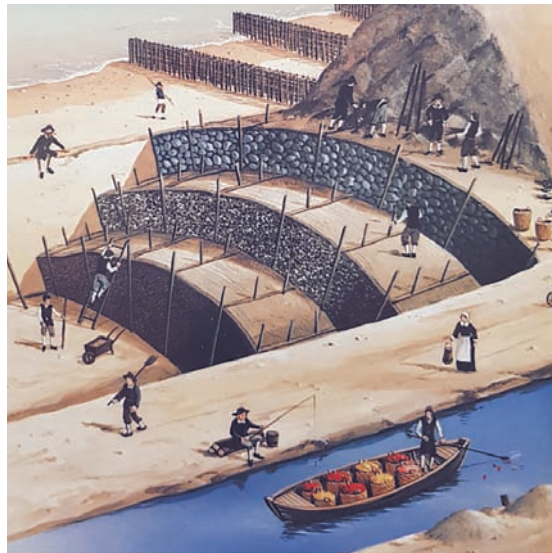
Будівництво дамби, яка відгороджує низини від моря
