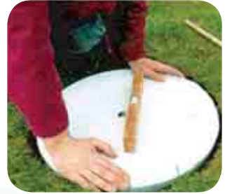
Мал. 213. Встановлення бетонного круга
