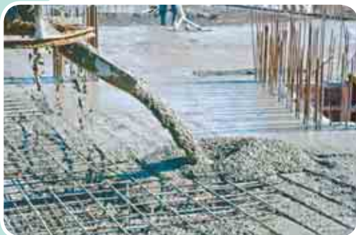
Мал. 26. Залізобетон — композит, який використовують у будівництві
