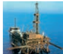
Platformă petrolieră de foraj în Marea Neagră (regiunea Sudică)
