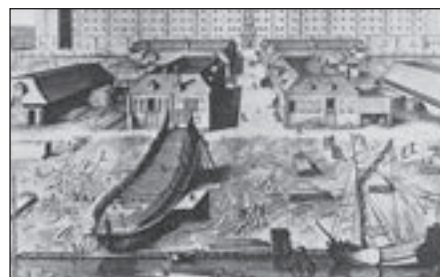
Construcția unei nave la șantierul din Amsterdam
