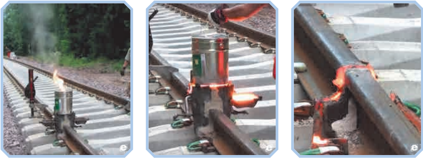
Рис. 40. Алюмотермітне зварювання рейок — єдиний спосіб швидко провести ремонт за мінімальних витрат
