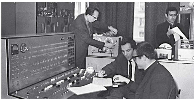
Rys. 1.7. Pult sterowania EOM „Mińsk” z różnymi systemami wprowadzania danych
